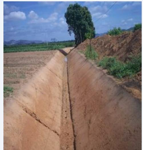
A seção de escoamento do dreno não é suficiente para escoar uma vazão de projeto de  $120 \text{ L s}^{-1}$ .
