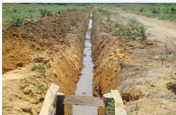
Os drenos abertos podem operar com as funções de remoção da água na parcela drenada (dreno lateral) e como coletor para transporte da água para região fora do terreno ou conexão com o dreno principal.
